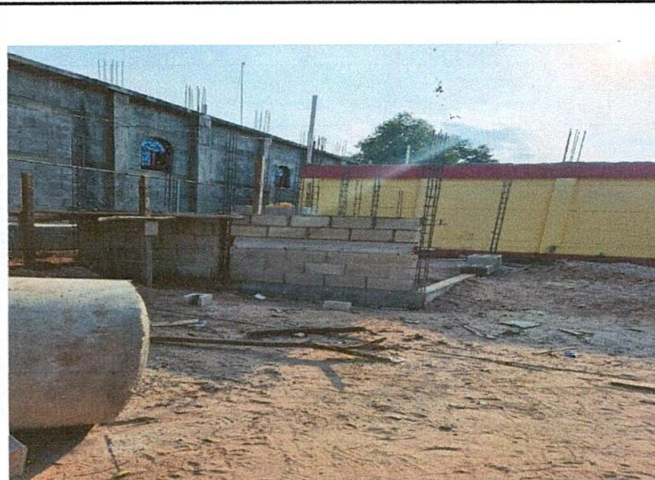
Foto 2: Área de mejoramiento de sanitarios e instalación de estructura tipo pórtico, estación de lavado de manos.
