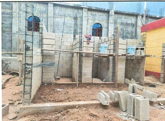
Foto1: Mejoramiento de los servicios sanitarios
